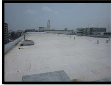
* 屋上防水の確認
