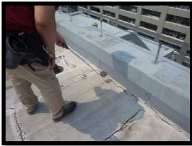
* 屋上防水の確認
