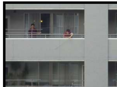
* バルコニー立入 外部タイル確認
