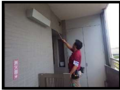
* 廊下タイル面(梁柱)打診確認
