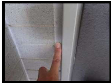
* シーリング、鉄部塗装の確認
