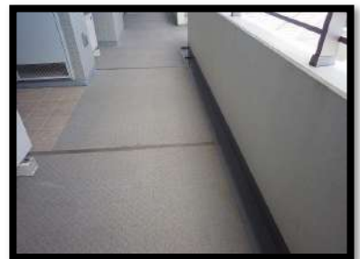
* 廊下床、手摺壁の確認
